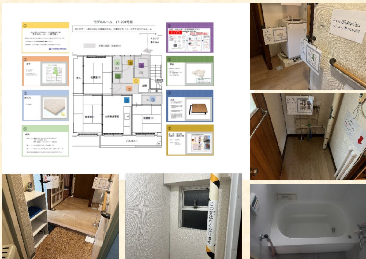
仕上げ状況を示した部屋
