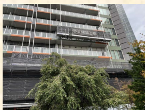
ゴンドラによる飛散防止措置
